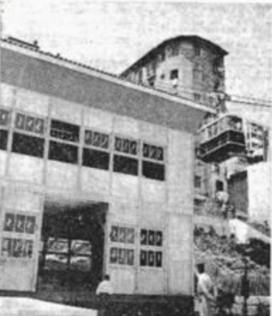
Édifiée au pied du séisme de Hamma, la mairie du 5 e arrondissement est sur le point d'être achevée (Photo « Echo d'Alger »)
